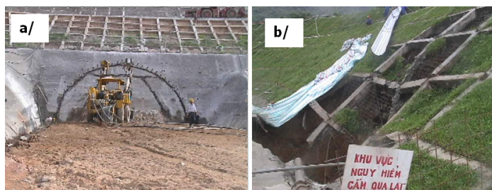
Hình 10 – Bờ dốc trên nóc cửa Nam hầm Hải Vân.
