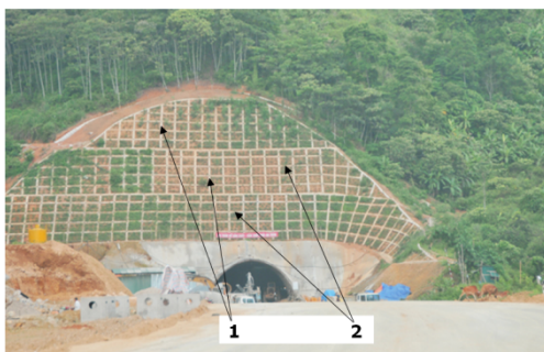
Hình 11: Cửa Nam hầm Cam Đường (đường cao tốc Nội Bài – Lào Cai đầu tháng 7/2013) [13].
