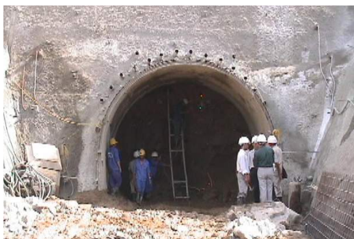
Hình 12. Cửa Nam nhánh phụ hầm Hải Vân chống sơ bộ bằng neo dọc dài, chống tạm thời bằng các vì chống thép chữ H có giằng cứng, rồi phụt bê tông lấp đầy và phun bê tông phủ bề mặt.
