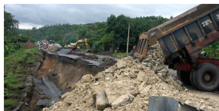
Hình 2: Cảnh khắc phục đoạn sạt lở Quốc lộ 1A qua thôn Cần Lương, xã An Dân, huyện Tuy An, Phú Yên. [2]
