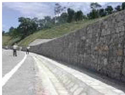
Hình 9: Tường rọ đá neo chống sụt trượt bên đường Hồ Chí Minh [8].
