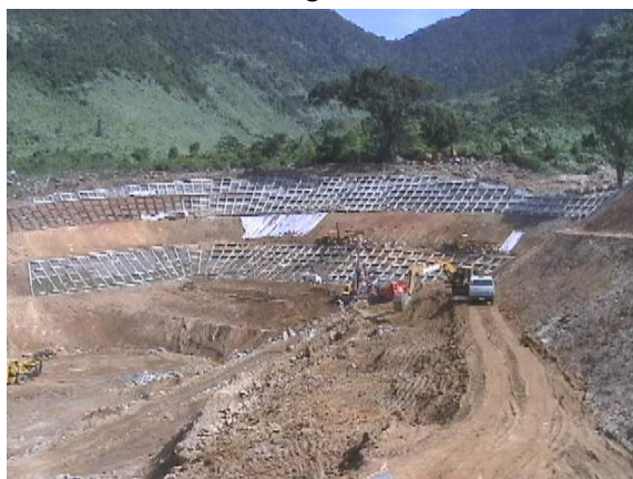
Hình 12: Thi công hệ thống dầm – giằng – neo gia cố các sườn dốc hào cửa nam hầm Hải Vân.
