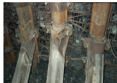
Hình 5. Mối liên kết dầm ngược
